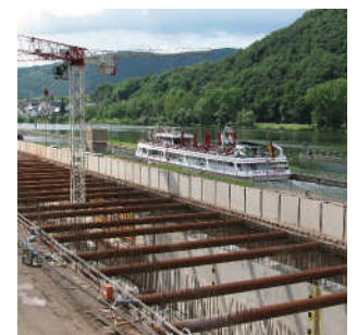
Betonarbeiten in der Baugru- be für die 2. Schleuse Fankel
