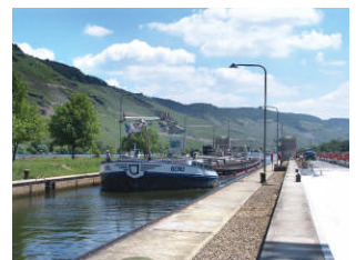
Großmotorgüterschiff bei der Einfahrt in die 1. Schleusenkammer Zeltingen
