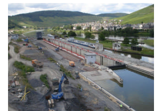
2. Schleuse Zeltingen bereit für den Probebetrieb
