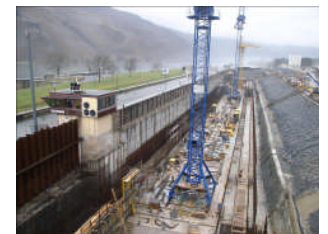
Blick in die Baugrube
