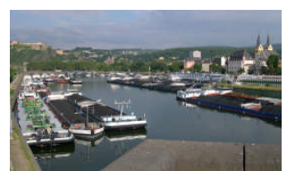
Wartende Fahrzeuge an der Eingangsschleuse Koblenz
