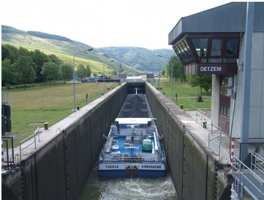
Abb. 3: Beladenes Gütermotorschiff beim Durchfahren der Schleuse Detzem
